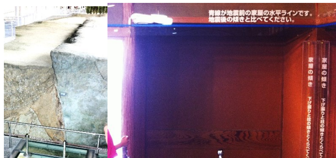
左：地震でできた断層のずれ。右：震災の家屋。上にあるラインの上に「震災前の水平ライン」という記載があった。
