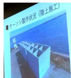
げて海中に沈め、中に石や砂を詰めて更にコンクリートの蓋をして土台を作る、という工法を説明していただいた。こんな工事は大手ゼネコンが受注して、子、孫、ひ孫会社が下請け工事に入ること。11年前の震災の被害が大きかった東北地域には、現在海岸沿いに10メートルを超すコンクリートの防潮堤が築かれて、景観は大きく損なわれてしまっているとの事。
