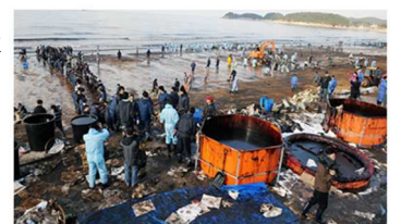
流れ出したオイルによる海水汚染を防がんと人海作戦(保寧)
